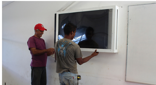
Instalación de pantallas en aulas
